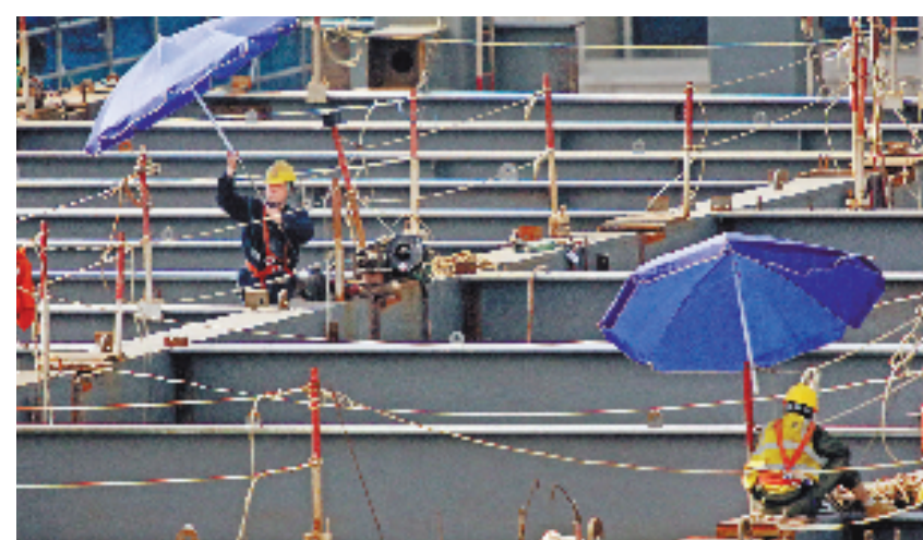
在浙江全民健身中心工地上,施工人员竖起遮阳伞遮挡阳光,确保工程进度。 本报记者 林云龙 摄
