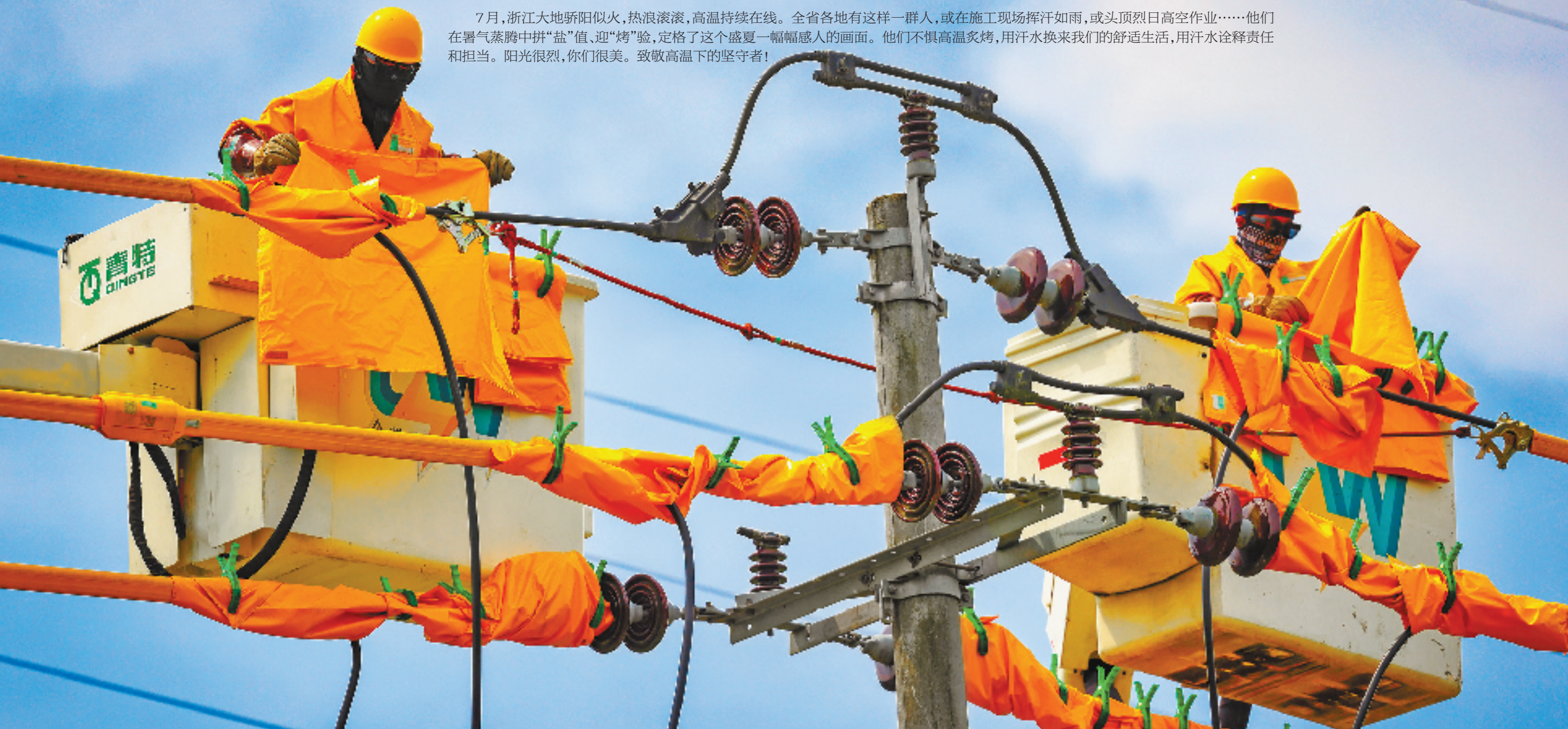
国网杭州市临安区供电公司员工在烈日下进行高空线路施工,守护清凉一夏。
