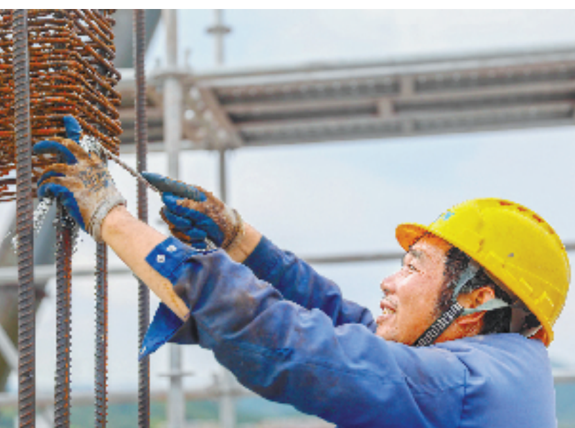
烈日下,浙江钜元建设集团有限公司的施工人员在建德市大同镇“五好两宜”和美乡村全国试点建设项目现场抓紧施工,保障项目进度。 拍友 罗素娟 摄
