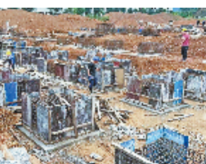
建设中的朝阳新村
