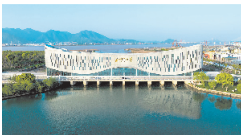
黄岩永宁江闸(图片由台州市黄岩区水利局提供)
