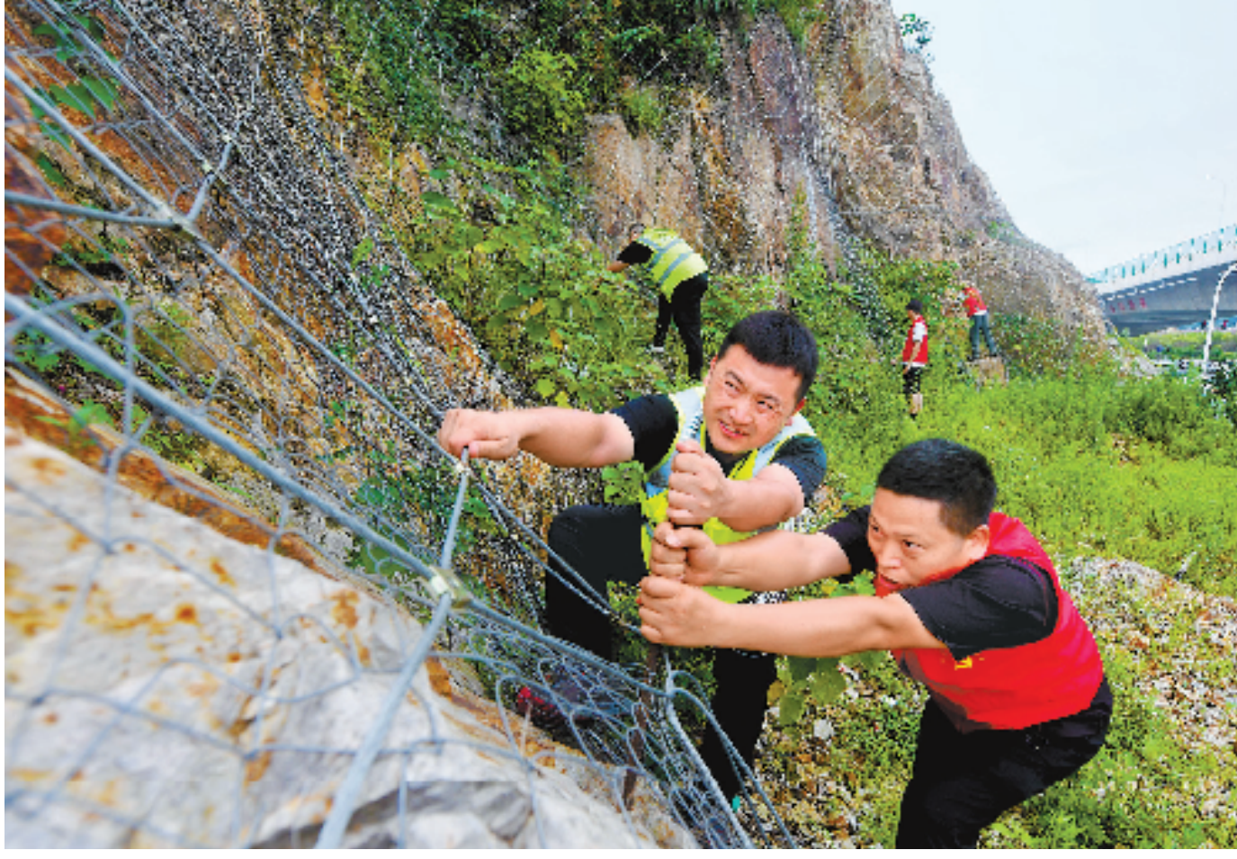
6月29日,台州市路桥区路南街道应急抢险队和“红口哨”党员先锋队为公路沿线和村庄周边山体加固防护网。
