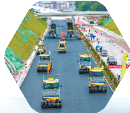
沥青路面施工
