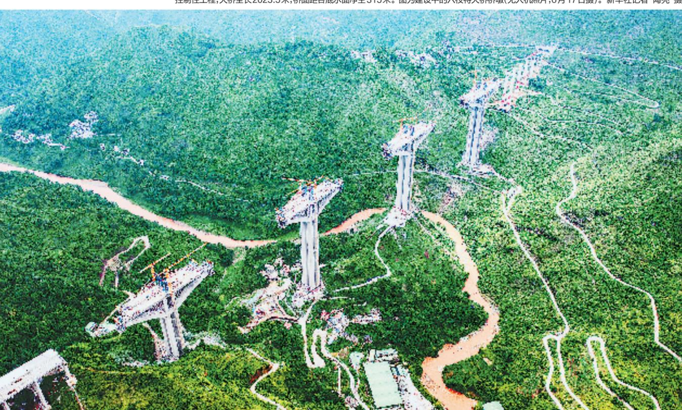
6月17日,随着六枝特大桥8.9号主墩空腹区交汇,由贵州交建集团所属路桥集团承建的纳晴高速六枝特大桥全桥上下弦全部完成“交会对接”,即将转入“刚构桥”施工阶段,大桥建设取得了阶段性胜利。六枝特大桥位于贵州省六盘水市六枝特区中寨乡境内,是纳雍至晴隆高速公路的控制性工程,大桥全长2023.5米,桥面距谷底水面净空315米。图为建设中的六枝特大桥桥墩(无人机照片,6月17日摄)。新华社记者 陶亮 摄
