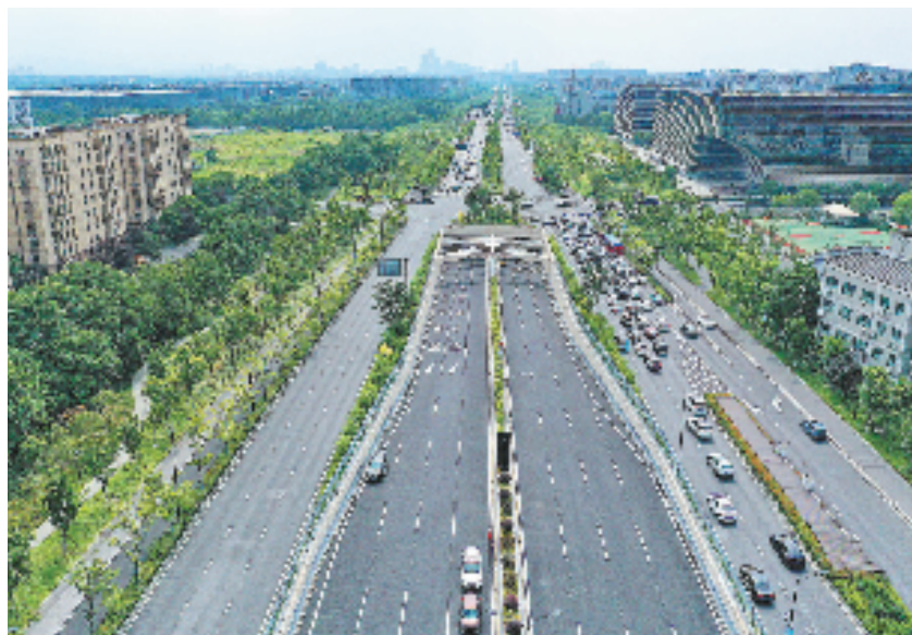
6月17日,杭州文一路(紫金港立交-荆长大道)提升改造工程的最后节点——文一路隧道已具备开通条件,计划于18日下午2时通车试运行。开通后,车辆可经快速路从钱塘区穿越市区直抵余杭区,55公里“一路无红灯”,同时意味着杭州绕城范围内“四纵五横”快速路网的断点全部打通,成环网的快速路网将为杭州社会发展和民生出行提供硬核支撑。文一路(紫金港立交-荆长大道)提升改造工程东起紫金港立交西侧,西至荆长大道以西,全长约4.06公里,地面道路为双向六车道主干路规模,快速路主线为地下隧道形式,隧道长3.87公里,采用双向四车道+紧急停车带形式,在蒋墩路设有一对进出匝道。 本报记者 林云龙 摄
