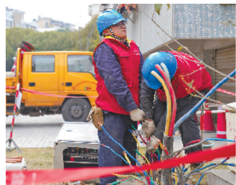
国网桐乡市供电公司红船党员服务队队员正在进行茗溪新村老旧小区电力改造收尾工作 沈佳炜 摄
