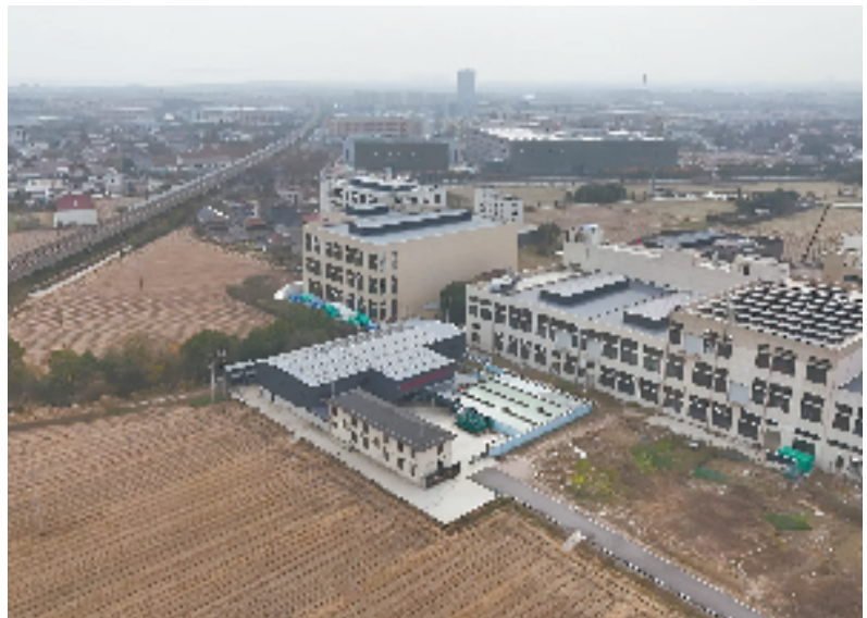
长兴县夹浦镇村集体经济项目（图片由夹浦镇提供）
