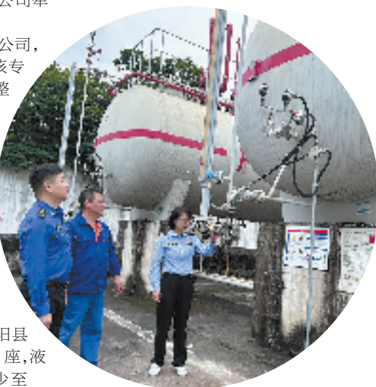
燃气专班人员在储配站开展燃气安全生产检查 (图片由平阳县综合行政执法局提供)
