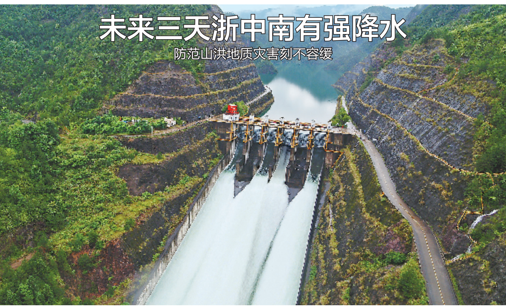
6月12日17时起,浙能滩坑水电站开启4扇溢洪道闸门有序预泄洪,为科学应对后续瓯江流域汛情做足准备。
