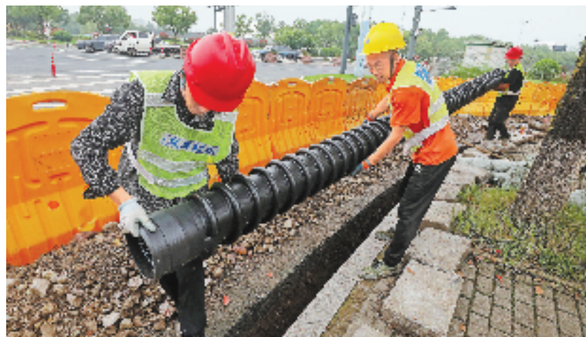
6月13日,义乌市政部门与水务集团对全市雨污水管网、雨污水井、泵站等设施进行排查整治。图为义乌市水务集团工作人员开展易积水点改造工程,目前已整改易积水点25处。
