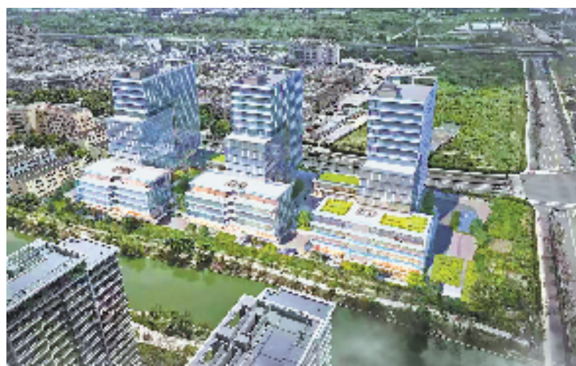
在建良渚三村村级留用地项目
