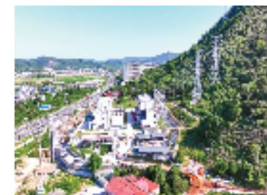
高桥变投运 冯静 摄
