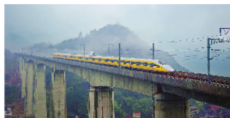
图为高速综合检测列车驶过杭温高铁楠溪江附近。 拍友 吕杰琛 摄
