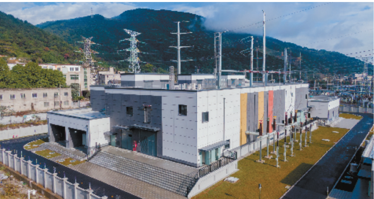
温州220千伏慈湖变电站获国家电网公司输变电标杆工程和中电建协智慧工程 张西 摄
