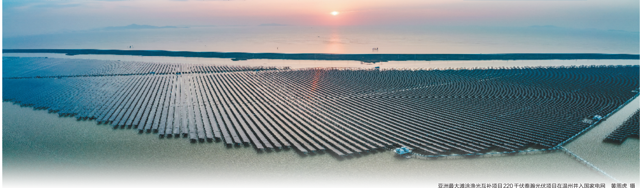
亚洲最大滩涂渔光互补项目220千伏泰瀚光伏项目在温州并入国家电网 黄周虎 摄
