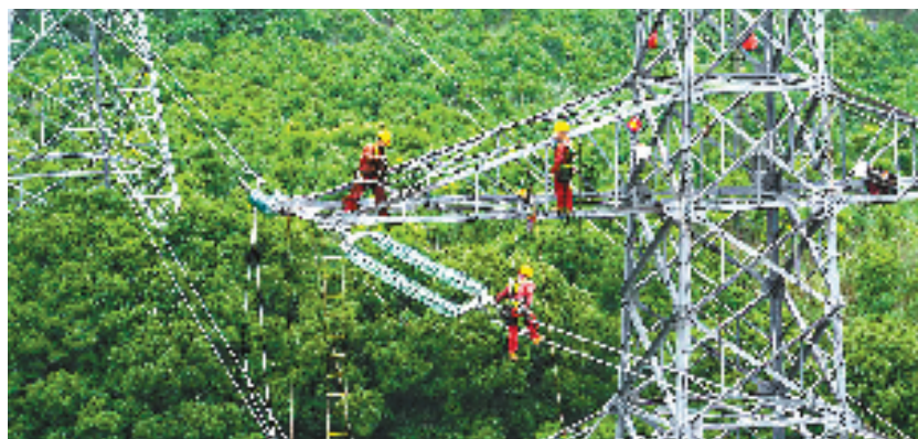
近日,浙江大有集团员工正在杭州富阳为亭中钱项目立塔架线。该工程将为我国首个220千伏柔性低频输电示范工程提供双回路电源输送通道,助力杭州城区之间富余电力灵活互济。 拍友 仲彦瑾 孔理 摄
