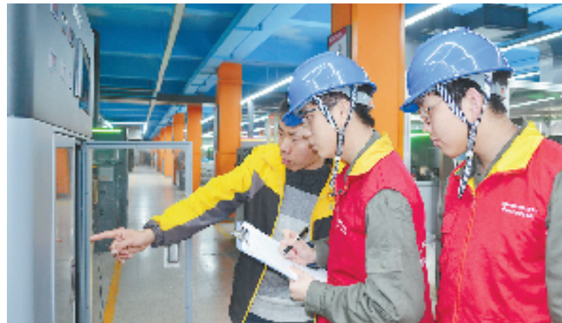
国网瑞安市供电公司员工对企业用电设施开展检查 李顺顺 摄
