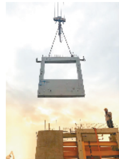
装配式建筑施工
