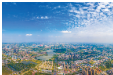
航拍吴兴 (图片由吴兴区住房和城乡建设局提供)
