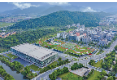
云栖小镇航拍(图片由杭州西湖云创集团有限公司提供)
