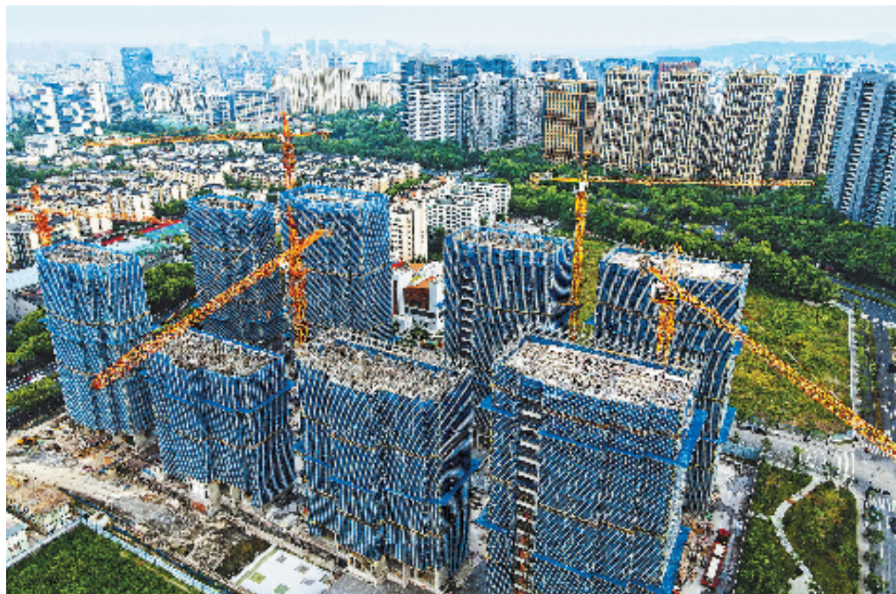
在杭州教工路上,一处住宅楼盘正在施工(5月9日摄)。
