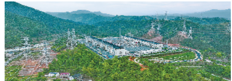
杭州建德500千伏输变电工程 沙鹏摄
