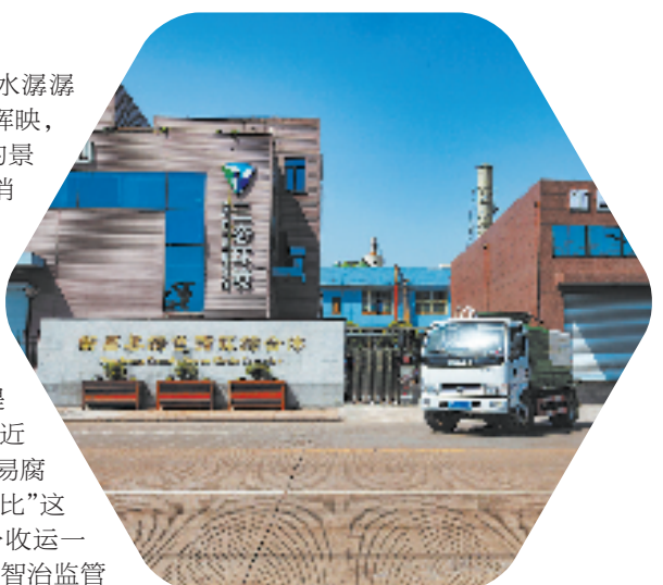
新昌县绿色循环综合体
