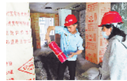
检查装修施工现场消防安全
