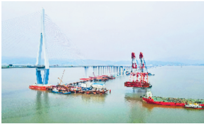
市域铁路象山线跨海大桥主墩首节钢围堰下放
