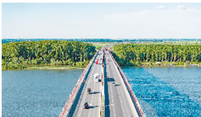
这是在塞尔维亚首都贝尔格莱德拍摄的泽蒙—博尔察大桥(普平大桥)(4月28日摄,无人机照片)。中国企业在欧洲承建的第一座大桥——泽蒙—博尔察大桥(普平大桥)2014年年底竣工通车,是塞尔维亚在多瑙河上近70年来首座新建大桥。新华社发(王隼 摄)
