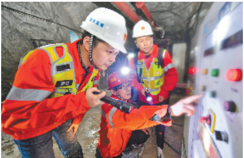
开展高危行业企业“常态化”“全覆盖式”安全生产检查,图为检查地下矿。
