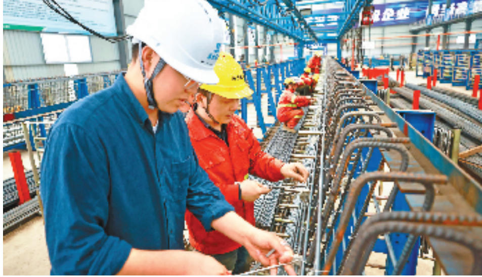
记者(左)跟着钢筋工黄秉武学扎钢筋。
