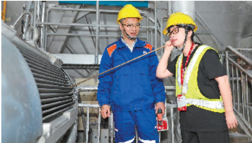
郑飞(左)指导记者用听棒听造纸机上烘干电机的声音。
