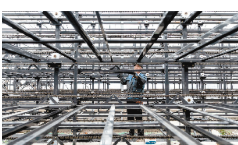
近期,在位于广陈镇的市乡村振兴稻米产业深度融合集成创新项目现场,工人正在工厂化育秧中心安装育秧盘。据介绍,该育秧中心采用立体化架构,可容纳20万个育秧盘同时育秧,大大节约了土地的使用,同时内部环境实现恒温,方便秧苗生长管理。 王强 李凤超 摄
