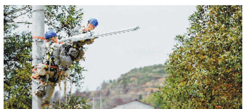
供电公司员工安装智慧光伏路灯 国网乐清市供电公司供图
