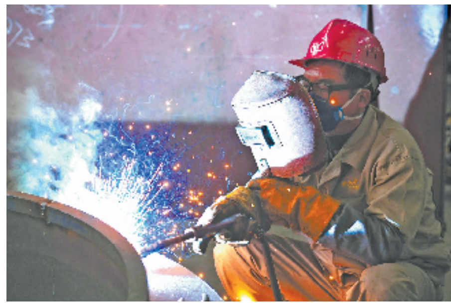
电焊工正在作业
