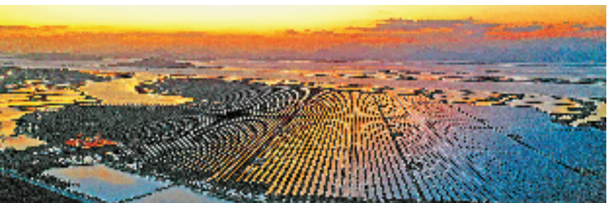
玉环市清港镇苔山村海涂华能130兆瓦“渔光互补”光伏发电站,24万多块单晶硅光伏板与晚霞交相辉映(本报资料照片)。拍友 段俊利 摄
