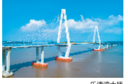
乐清湾大桥 (图片由浙高运公司提供)
