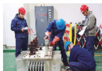
变压器绝缘电阻测试 谢锦 摄
