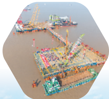
通苏嘉甬铁路修建现场
