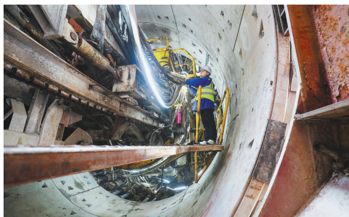
3月7日,在湖州市德清县康乾街道的杭德市域铁路项目高铁站施工现场,杭德市域铁路1标段开始最后一个区间工程的施工。
