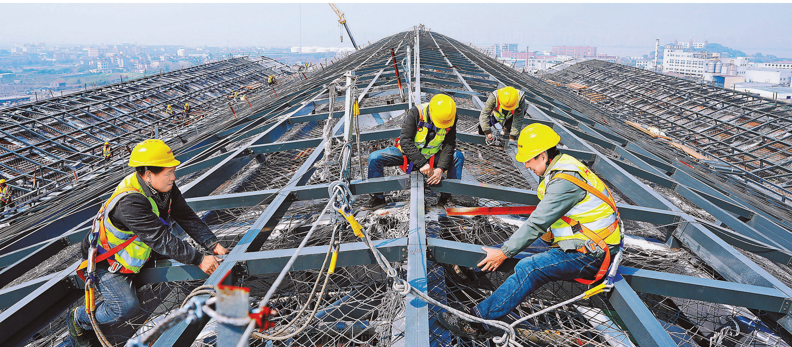
3月7日 杭州大会展中心一期项目施工现场热火朝天,工人们正在为中廊顶部贴玻璃幕墙,4月底将完工。
