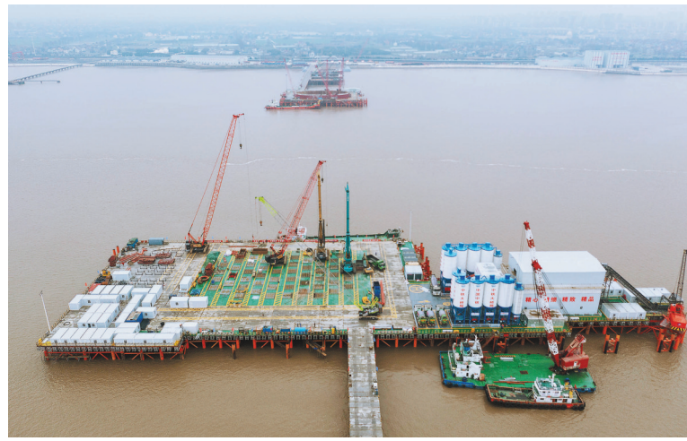
近日,嘉兴海盐,中铁大桥局杭州湾跨海铁路桥项目9号墩的海上施工平台上,大型施工机械穿梭忙碌,北航道桥9号主塔首个钻孔桩进入开钻阶段。
