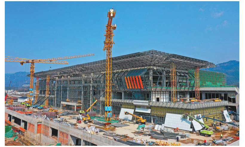
3月8日,杭温高铁东阳市横店站房项目建设现场一片火热施工景象,建设者铆足干劲,全力冲刺通车“收官战”。
