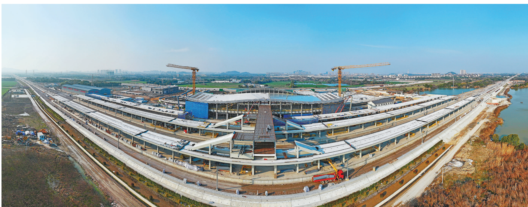
3月8日，作为沪苏湖铁路与合杭高铁湖杭段的衔接站，湖州东站项目建设已进入装饰装修及机电安装阶段，候车大厅和站台初现雏形。
