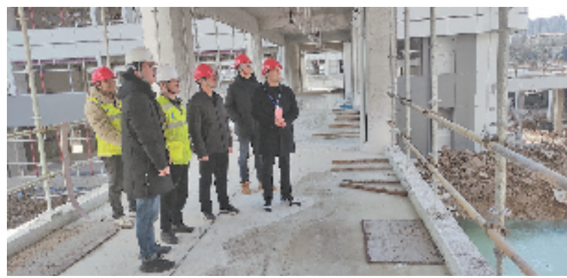
开展复工复产安全检查 (图片由兰溪城投集团提供)
