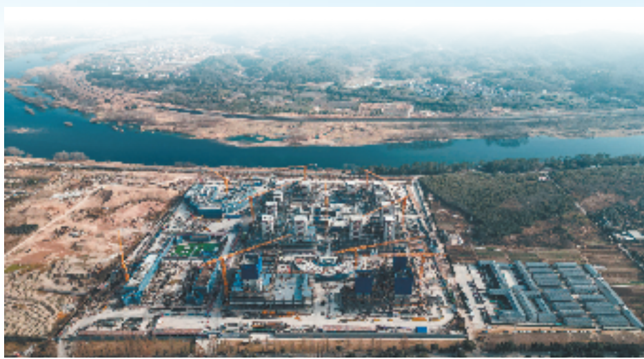
莲都区白桥双创中心项目 严海华 摄
