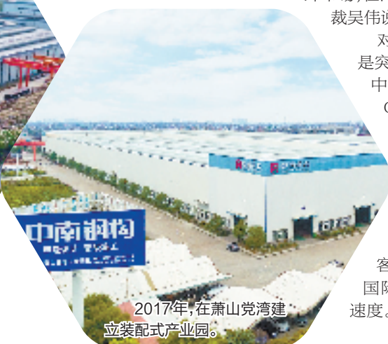
2017年在萧山党湾建 应装配式产业园。
