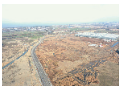
位于湖州吴兴高新区的吴士2024(工)-08号地块(图片由吴兴人才产业投资发展集团有限公司提供)
