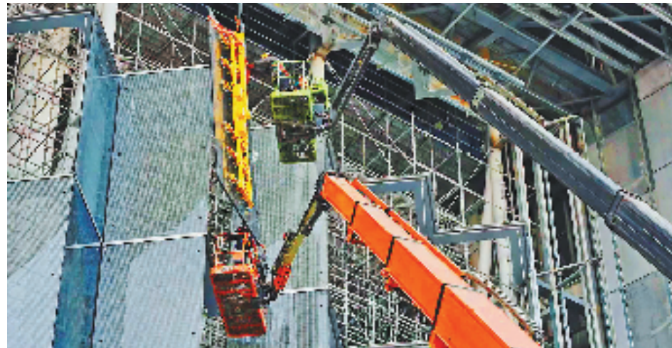
建设中的杭州大会展中心一期。
