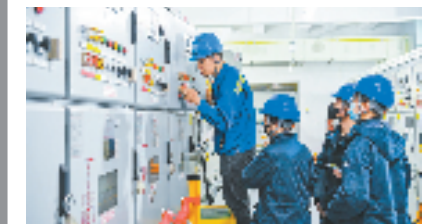
1月27日,国网慈溪市供电公司的工作人员在110千伏新都变对新增设备进行调试。姚科斌 摄
