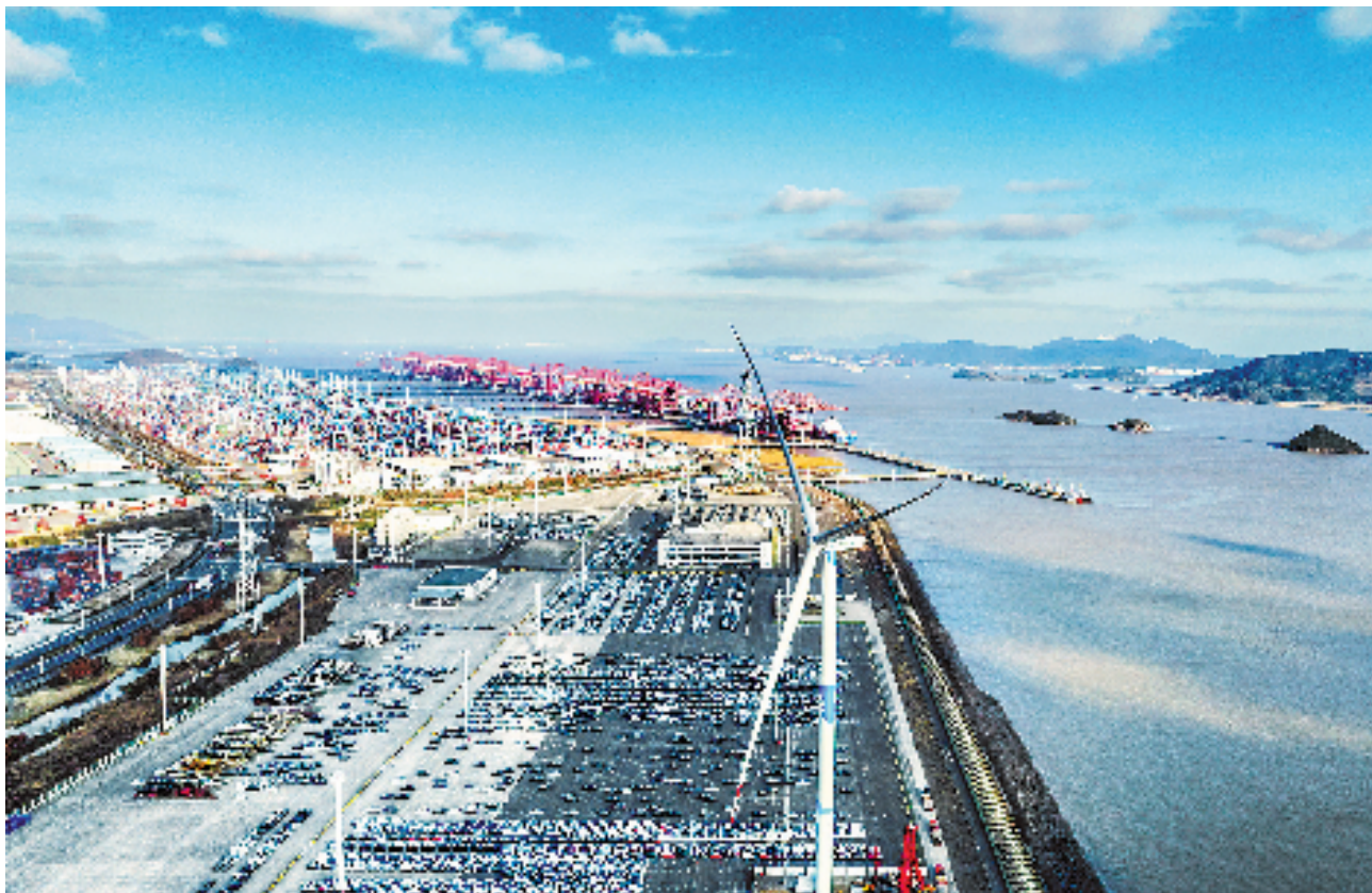
梅山低碳码头示范工程风光储一体化项目首台风电机组并网发电。
