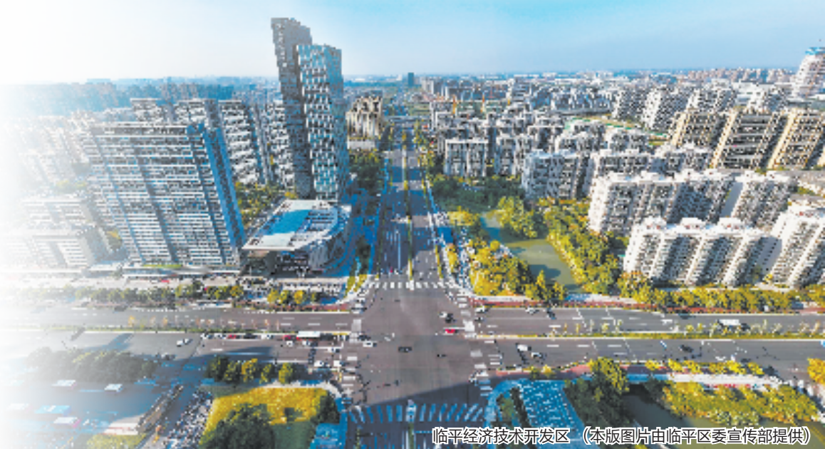
临平经济技术开发区（本版图片由临平区委宣传部提供）
