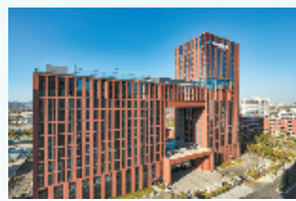
杭州光机所一期建成投用
