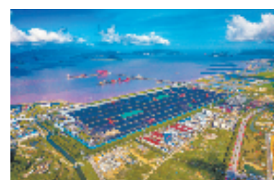
六横新煤港码头 徐复尧摄
