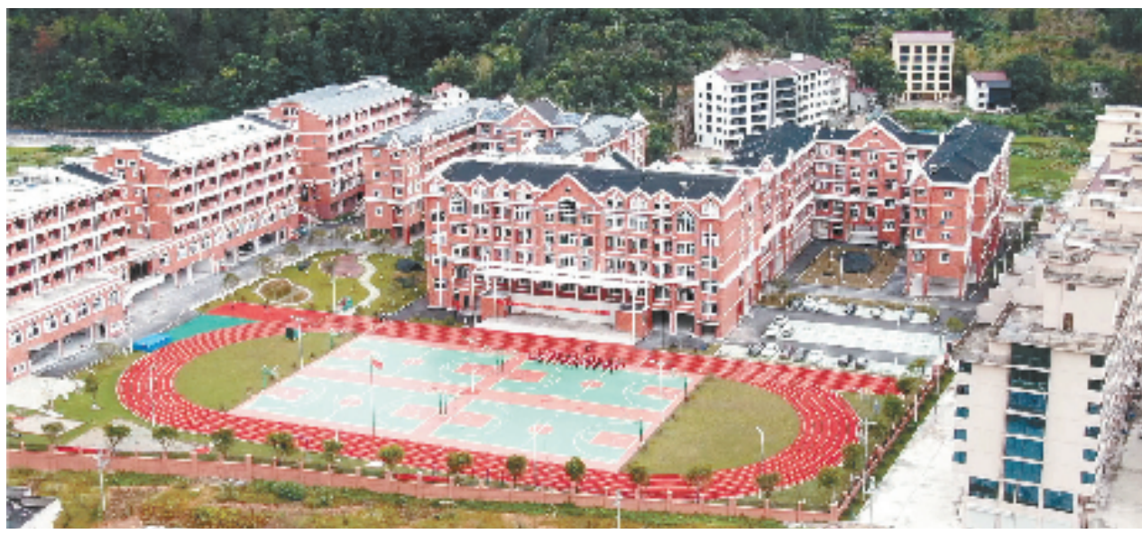
青田县第二中学湖边校区二期工程(局部)
