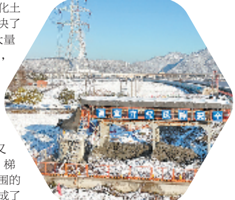
双龙汇龙段施工现场
